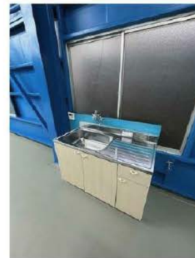
給湯器設備新規設置
